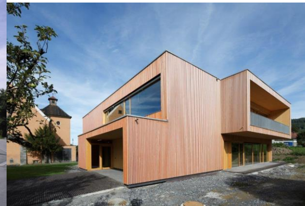
Passivhaus KIGA Muntlix
