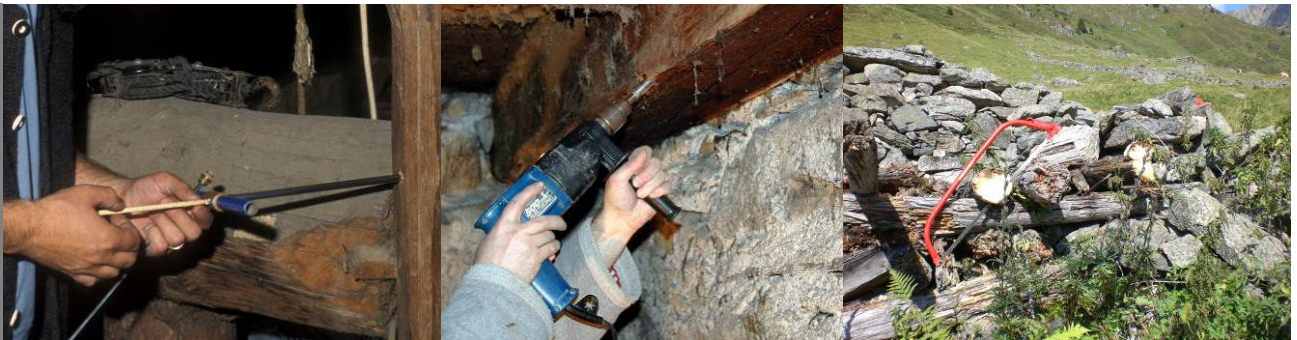
Schlüssel zum Bauarchiv – Probenbergung (Hohl-/Fräsbohrer, Bügelsäge)
