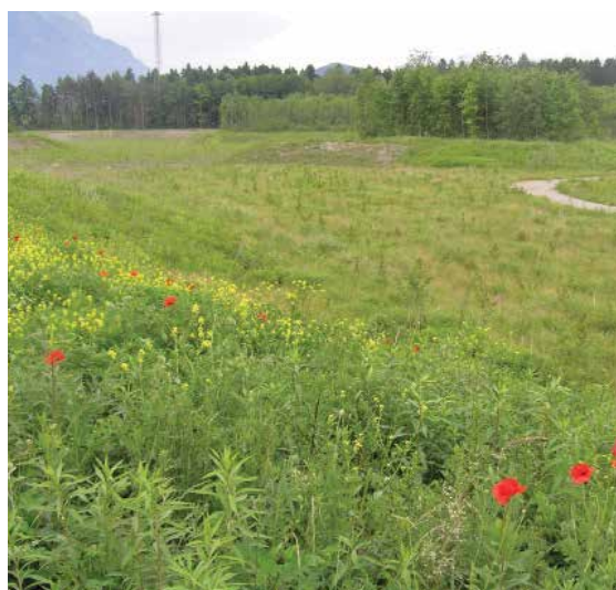
Retentionsbecken Rüttenen nach der Fertigstellung im Jahr 2011.
