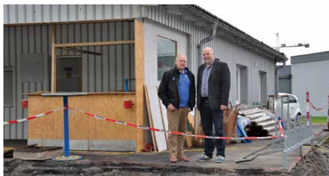
SK-Obmann Herbert Güfel und Bgm. Thomas Pinter beim Baustart. | Fotos: Benzer
