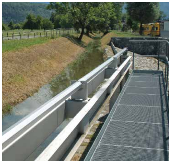
Die Anlage an der Nafla für das Retentionbecken Rüttenen (2011).
