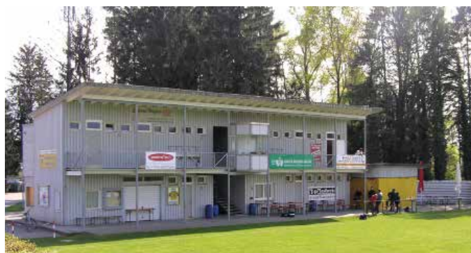
Ausgedient - das alte Clubheim des SK CHT Austria Meiningen.
