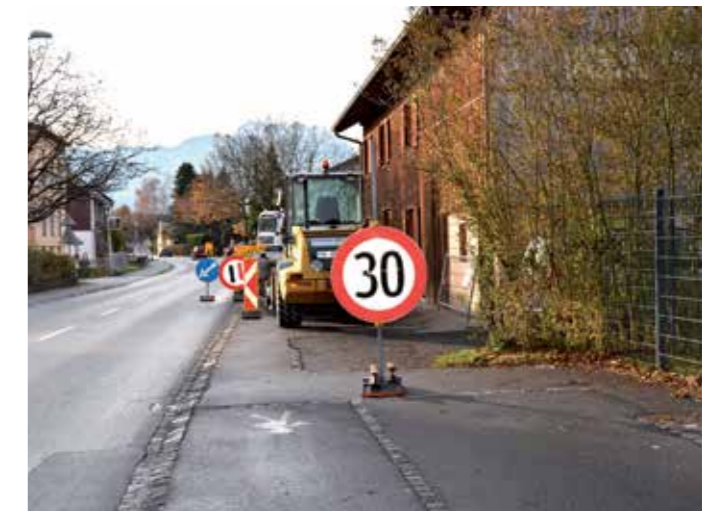
Gehsteig Raiffeisenbank - Haltestelle Bim Krüz | Fotos: Benzer
