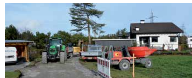
Oben: Sanierung Agathaweg. Unten: Sanierung Dorn.
