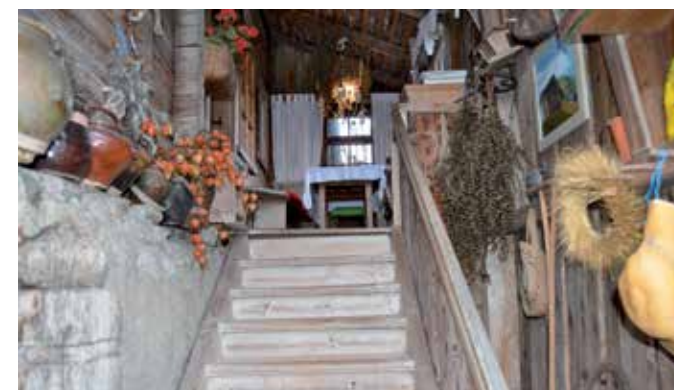
Steinsockel mit aufgesetztem Holzriegel. Aufgang in den Wohnbereich.
